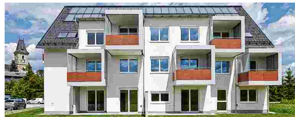
In Kronstorf entstand 2014 ein Niedrigenergiewohnhaus mit acht Wohnungen.
