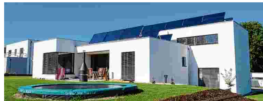
Hans Achatz nützt die Energie der Sonne zum Heizen und Kühlen.
