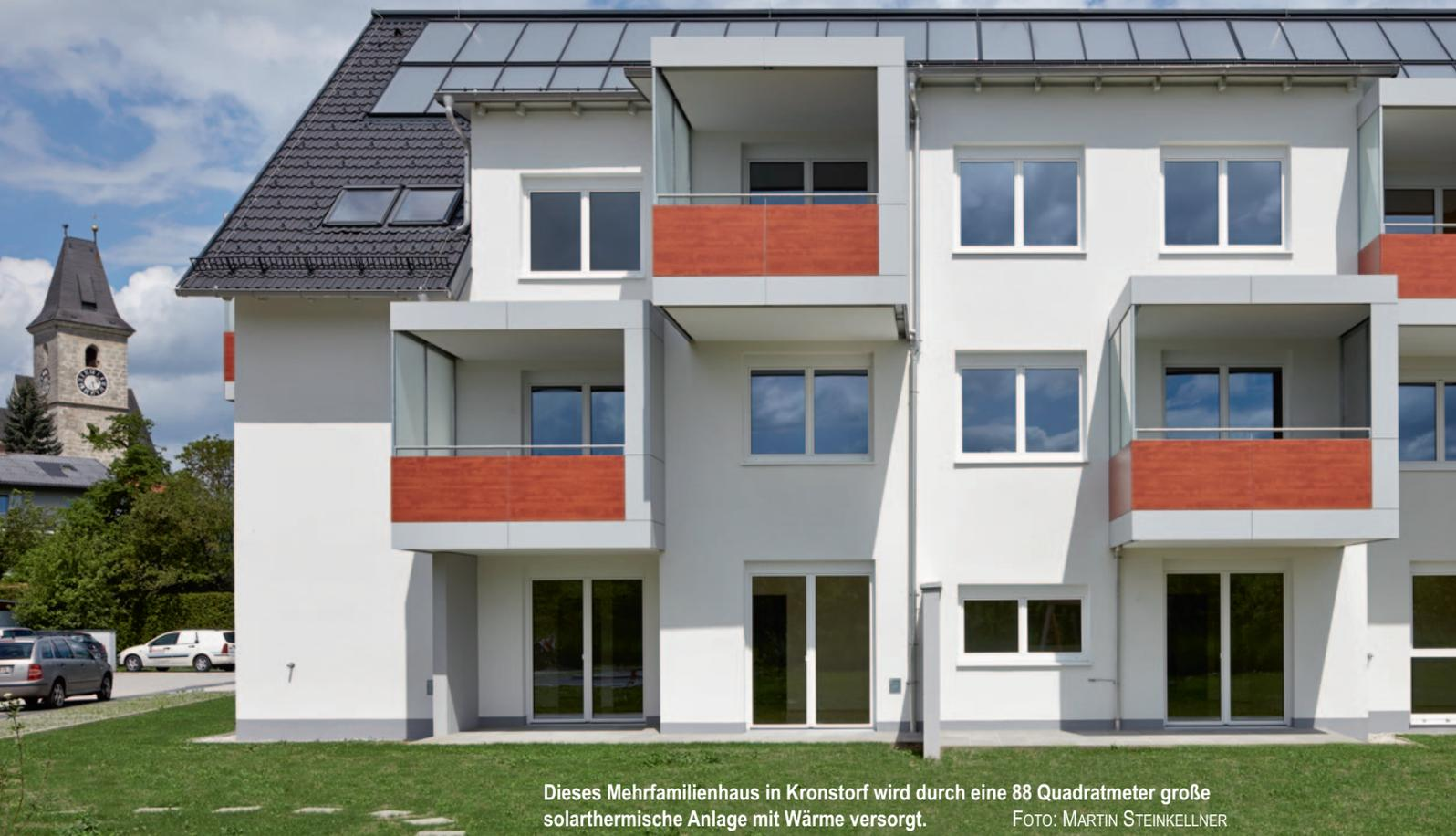
Dieses Mehrfamilienhaus in Kronstorf wird durch eine 88 Quadratmeter große solarthermische Anlage mit Wärme versorgt. FOTO: MARTIN STEINKELLNER
