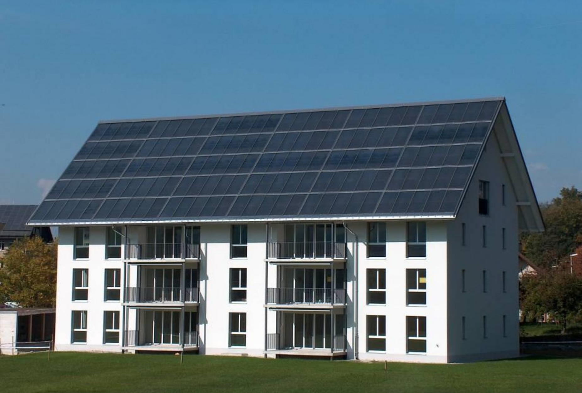
100 % Solare Wärme Heizung und Warmwasser
