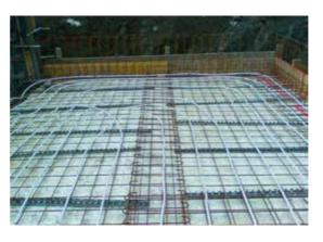
Durch Kunststoffoder Kupferrohre werden massive Betonteile aktiviert, sodass sie Wärme speichern und verteilen können.
